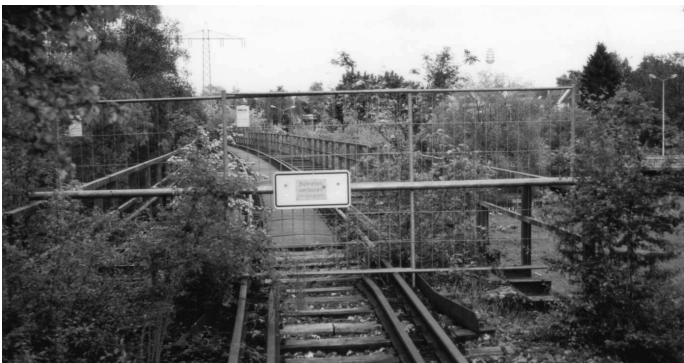
Abb.9: Zu den aufwändigsten Maßnahmen gehört die Sanierung der Brücken. Mitte der 90er Jahre wurde die Brücke über die Rednitz vollständig gesperrt.
